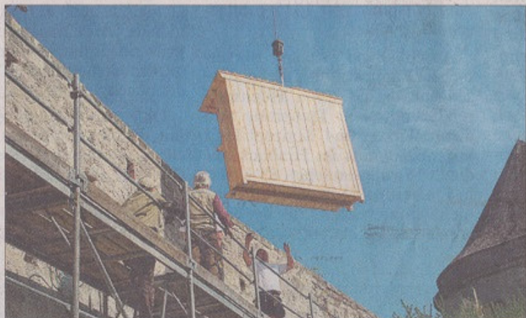
Mit Hilfe eines Krans wurden die hölzernen Brutkästen an ihrem Standort an der Wehrmauer fixiert. – Foto: P. Przesang
