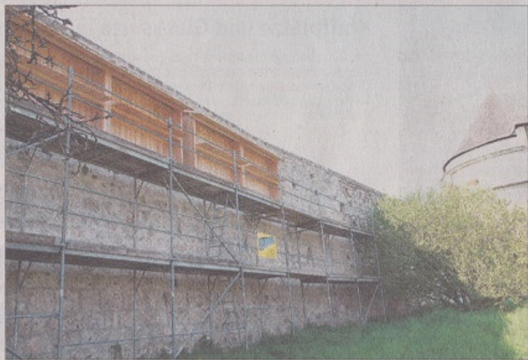
Die Brutnischen an der Wehrmauer beim Pulverturm sind installiert und werden ab kommendem Jahr den Vögeln als Nistplatz dienen.
